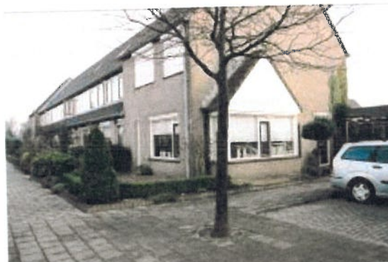
Nieuwbouw met bijzondere hoekwoningen aan de Veenestraat
