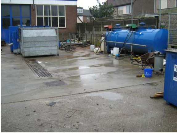
Foto 3: Was- annex tankplaats met de bovengrondse tank en direct voor de betonverharding de bestaande peilbuis
