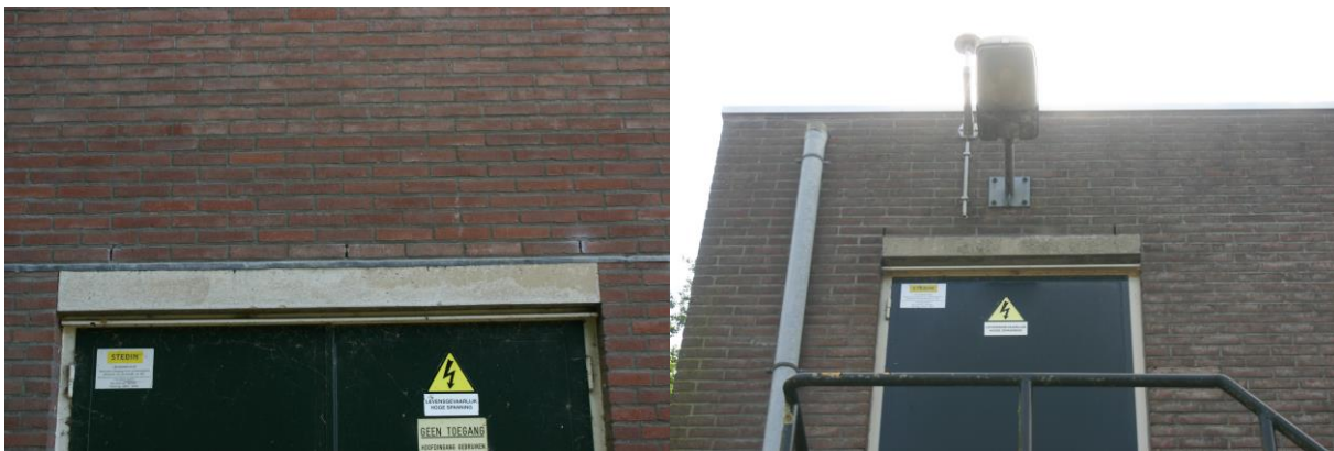
Figuur 4.4.2. De buitengevels van het gebouw met open stootvoegen.
