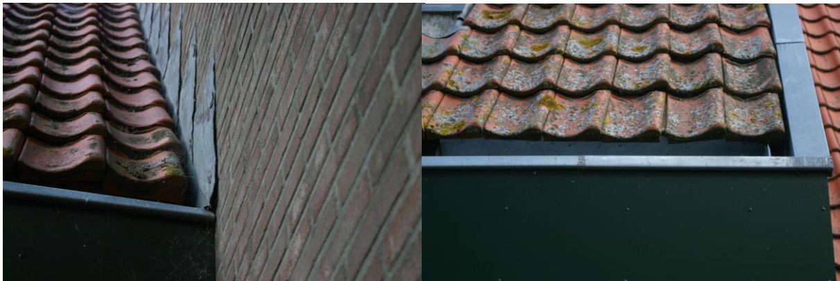
Figuur 4.4.1. Vogels en vleermuizen hebben geen toegang tot de ruimtes onder de dakpannen.
