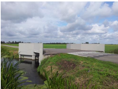
Betonbrug in de Bloklandseweg (waarschijnlijk ca 1960)
