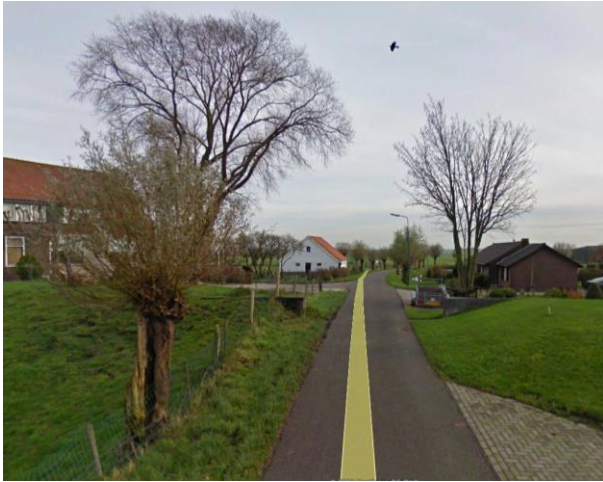
Eemdijk nabij Maatweg 1, Dijkgat met betonnen schotbalkspinningen (Google earth)
