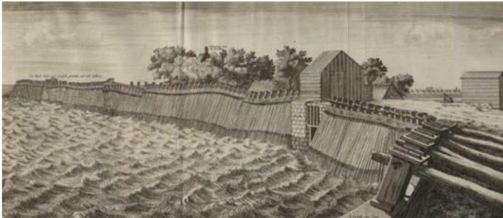
Ter bescherming waren dijken nodig. Een bijzondere dijkconstructie werd toegepast in de vorm van een palendijk.
