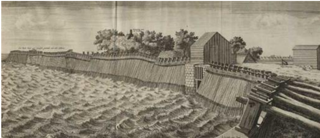
Ter bescherming waren dijken nodig. Een bijzondere dijkconstructie werd toegepast in de vorm van een palendijk.
