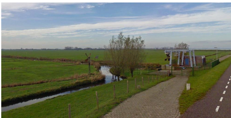
Zicht op gemoderniseerd gemaal in de Westdijk. Links staat een Bosman-molentje.
