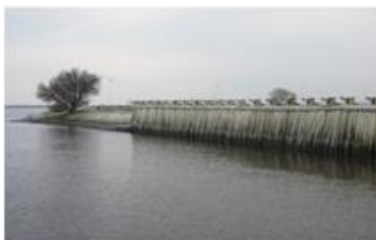
Nabij Oude Pol, bij de overgang van de Eemdijk in de Westdijk, is een stukje van de Palendijk gereconstrueerd.
