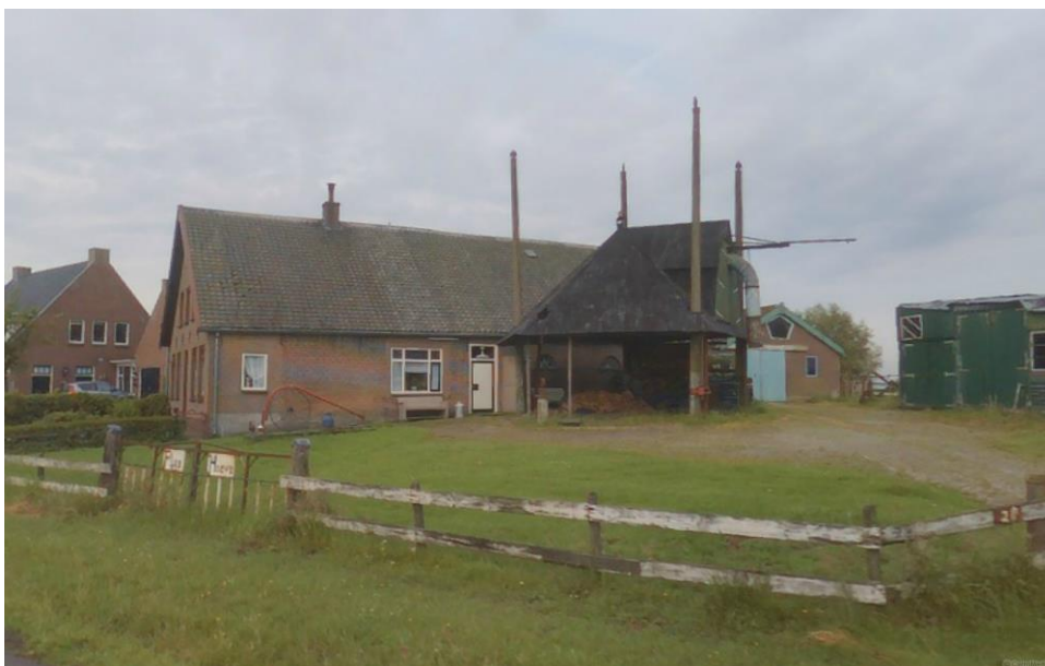
Eemdijk 28, karakteristiek boerderij met hooiberg
