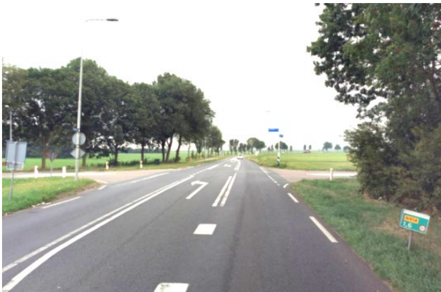
Figuur 12: kruispunt Bisschopsweg-Eemdijk/Zuidereind, gezien vanaf de Bisschopsweg zuid
