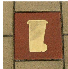
markering opstelplaats huisvuil containers
