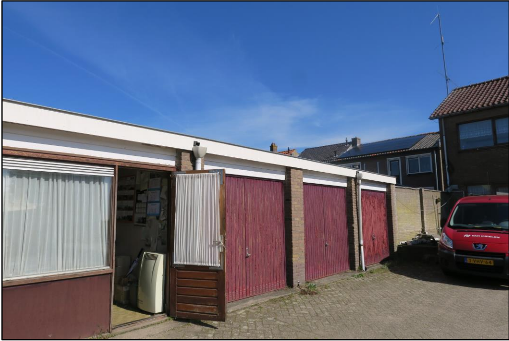
Figuur 3 Gebouw C, bestaande uit drie garages en een kantoorruimte.
