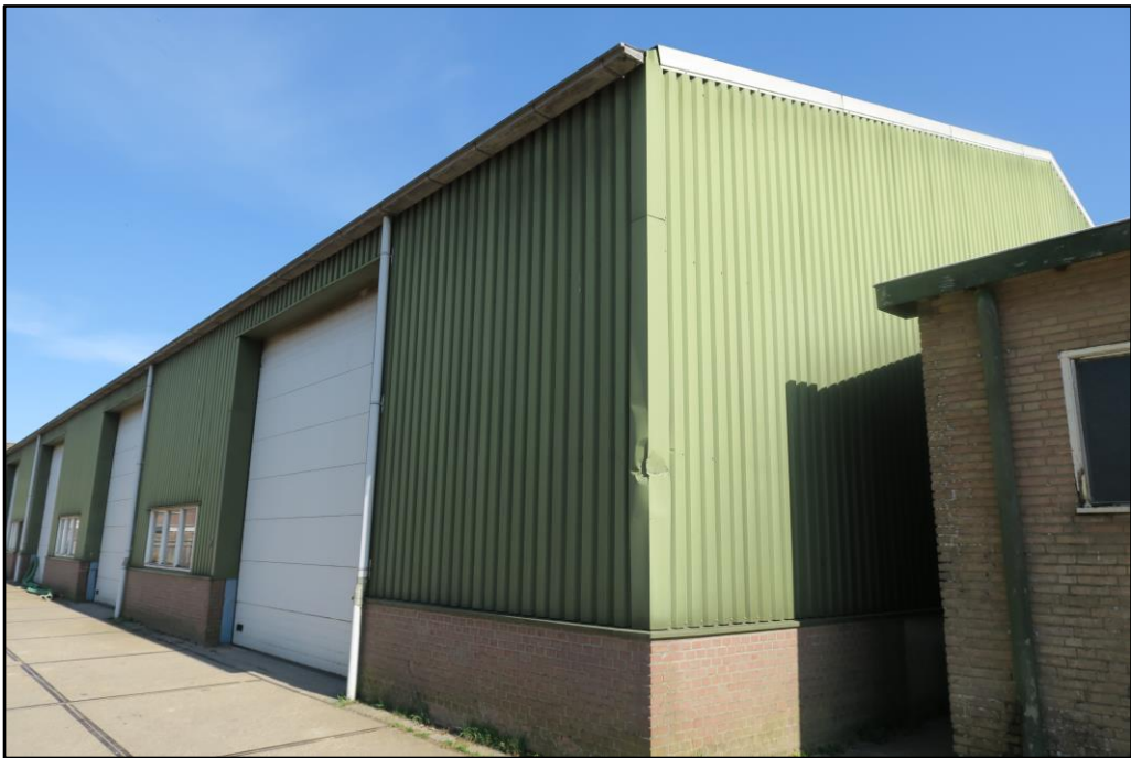
Figuur 4 Gebouw D, bestaande uit damwandplaten met een golfplaten dak.
