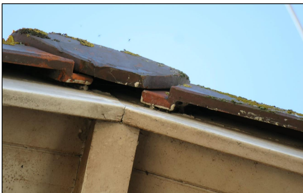
Figuur 4 Kantpannen gebouw A met invliegmogelijkheid voor vleermuizen.
