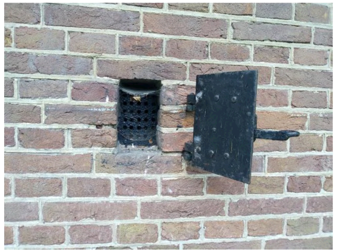
Foto's 3 en 4: detail oorspronkelijke en te handhaven ventilatieopeningen.
