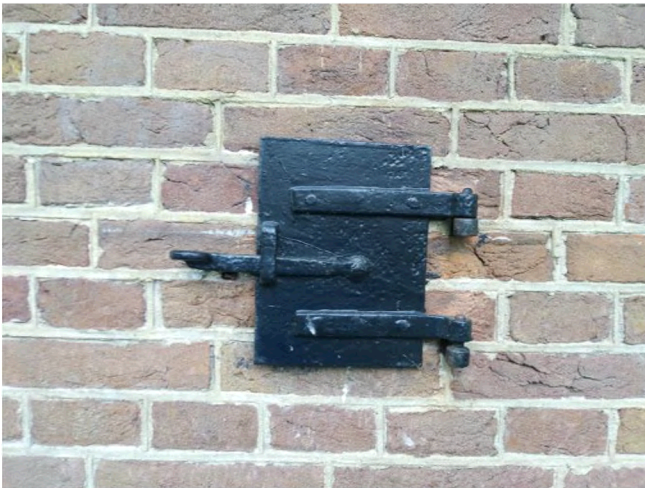
Foto's 3 en 4: detail oorspronkelijke en te handhaven ventilatieopeningen.
