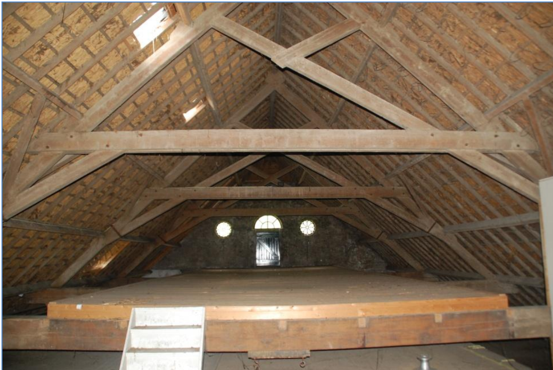
Nog aanwezige dakspanten, met ontbrekend deel.
