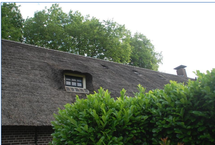
Bestaande dakkapel en dakramen in bovenste deel van het dak.
