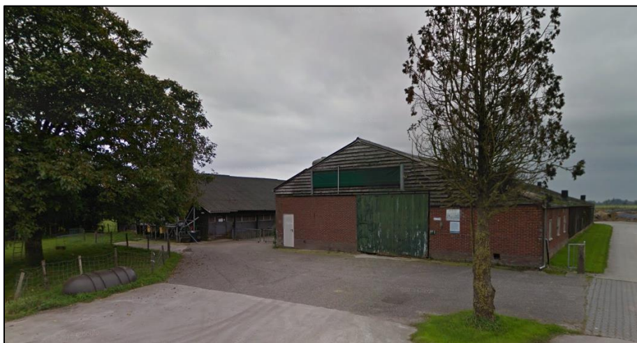
Slooplocatie Ossenwaard 15 0001, Cothen (bron: Google Streetview, oktober 2015)
