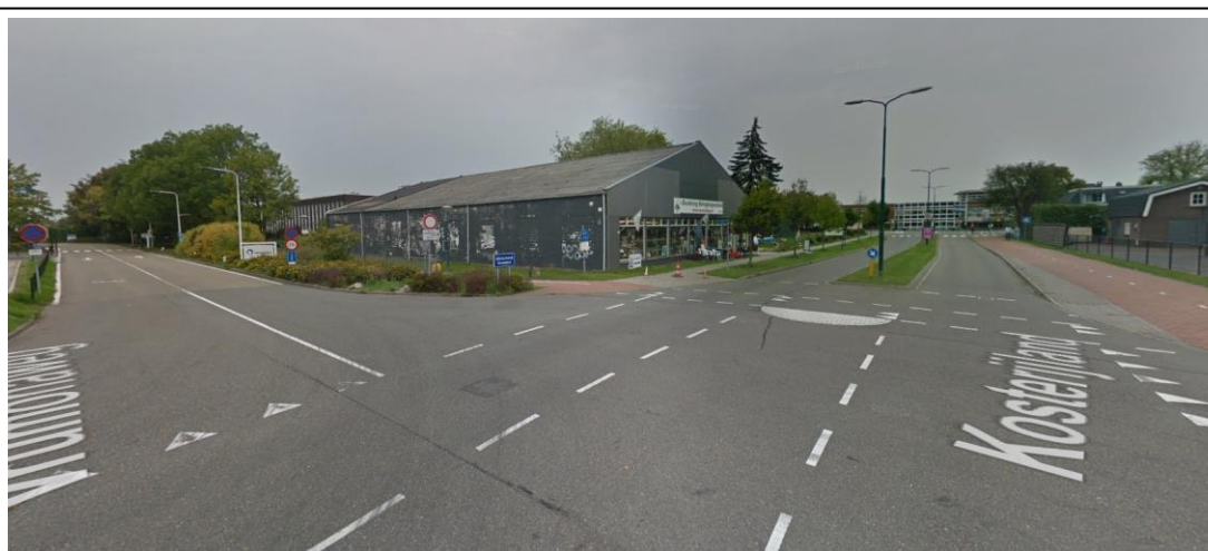
Figuur 7 – Huidige bedrijfsloods (Schoudermantel 6a), gezien vanaf de kruising Kosterijland – Vrumonaweg (bron: Google Streetview)
