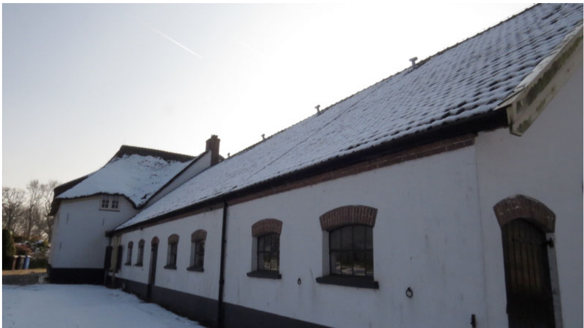
Foto 3. Zicht op de bestaande boerderij. Het pand biedt aan deze zijde en aan de andere zijden potenties voor gebouwbewonende vleermuizen door de toegankelijkheid naar inpandige ruimten tussen de dakgoot en de stenen bovenrand van de buitenmuur.
