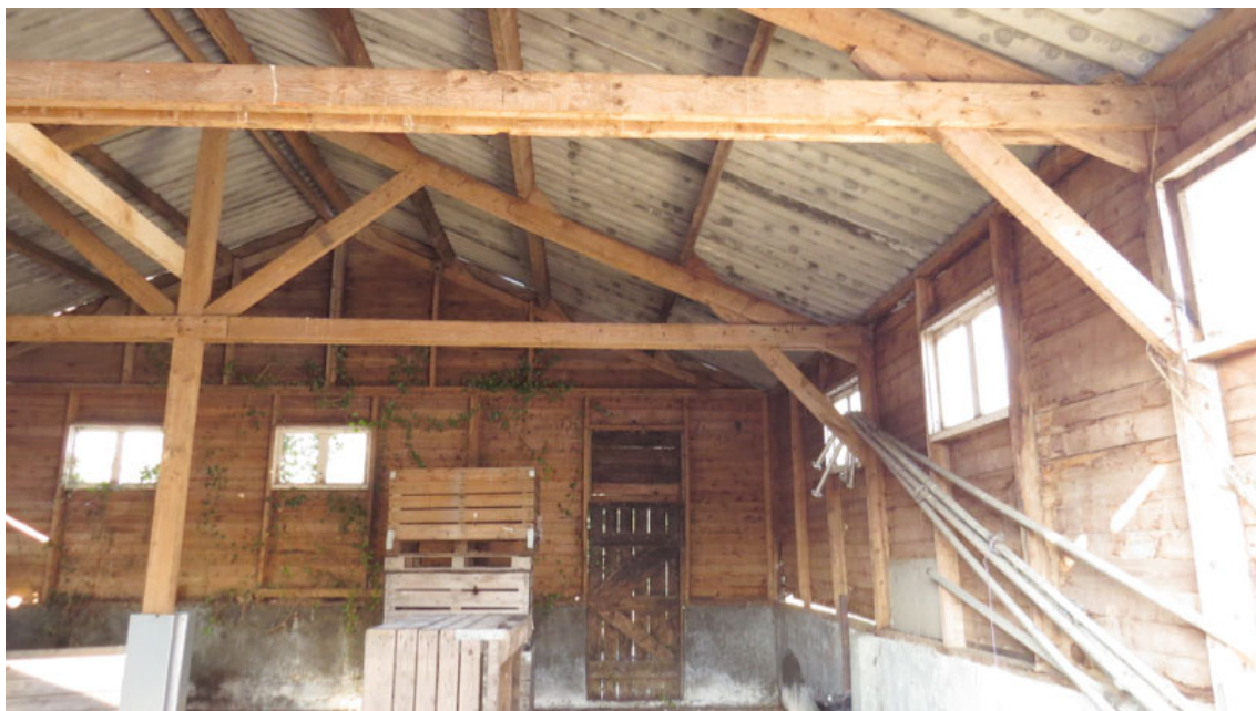
Foto 4. Zicht op de binnenkant van de houten schuur. Er zijn geen wegkruipmogelijkheden omdat de dakbedekking en muren uit één laag bestaan. Ook ontbreekt de geschiktheid als (winter)verblijfplaats door de vele spleten, kieren etc, en de daardoor overheersende tocht (waardoor afkoelings- en/of uitdrogingsgevaar bestaat).
