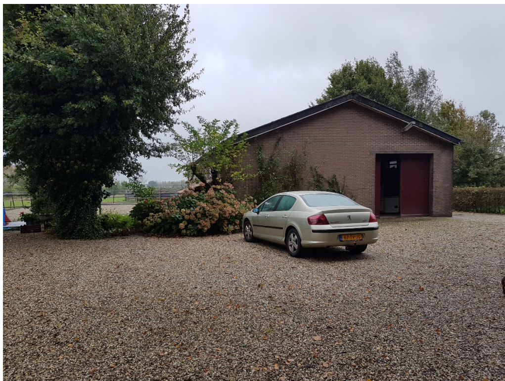
Figuur 2 Aan de achterzijde van het woonhuis is een voormalige paardenschuur gesitueerd. Deze schuur alsmede de woning blijven behouden.
