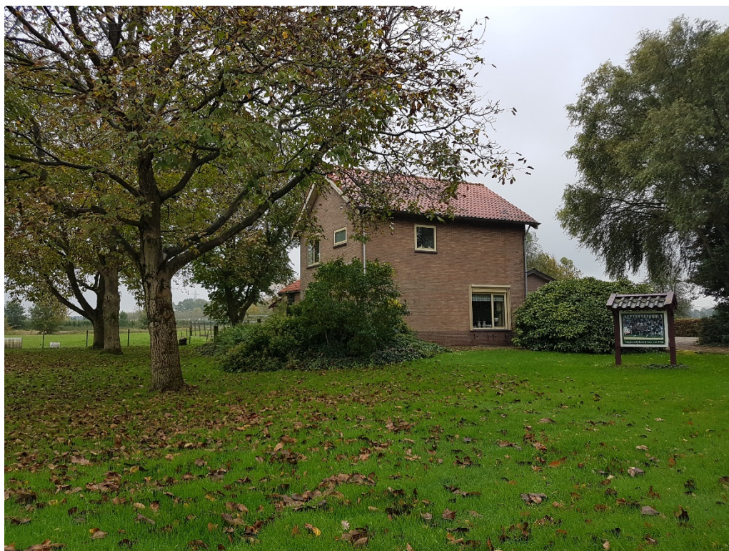
Figuur 1 De planlocatie is gelegen aan Parallelweg 3 te Bunnik. Binnen het plangebied zijn een woonhuis met aangrenzende siertuin en grotere bomen aanwezig.
