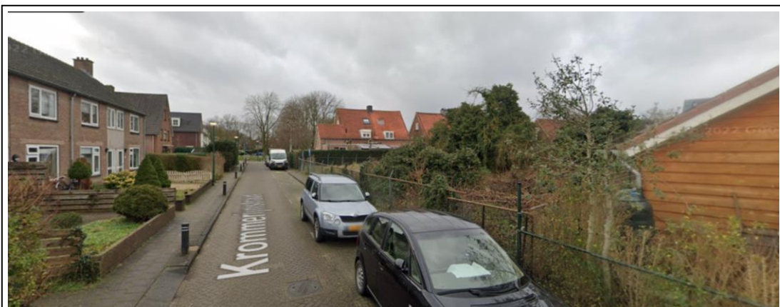
Figuur 7 – Huidig beeld plangebied vanaf de Krommerijnstraat (bron: Google Streetview)
