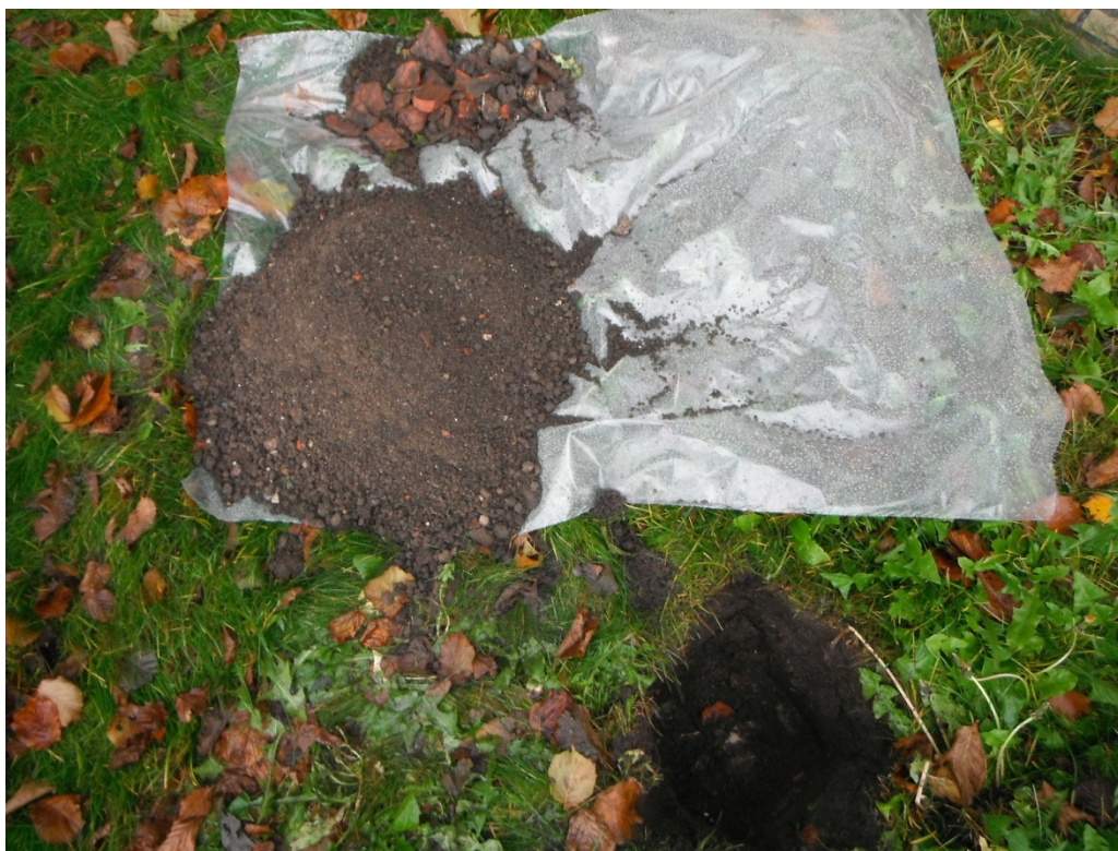
Foto asbestinspectiegat ASB 2.
