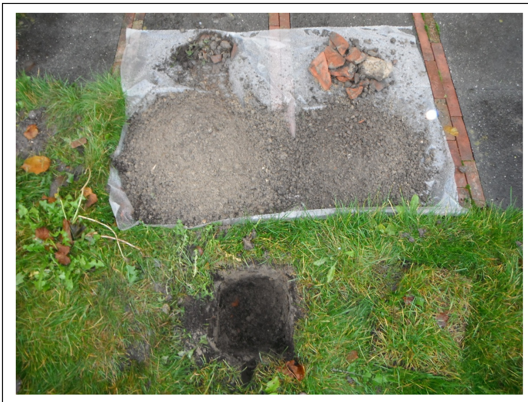
Foto asbestinspectiegat ASB 3.
