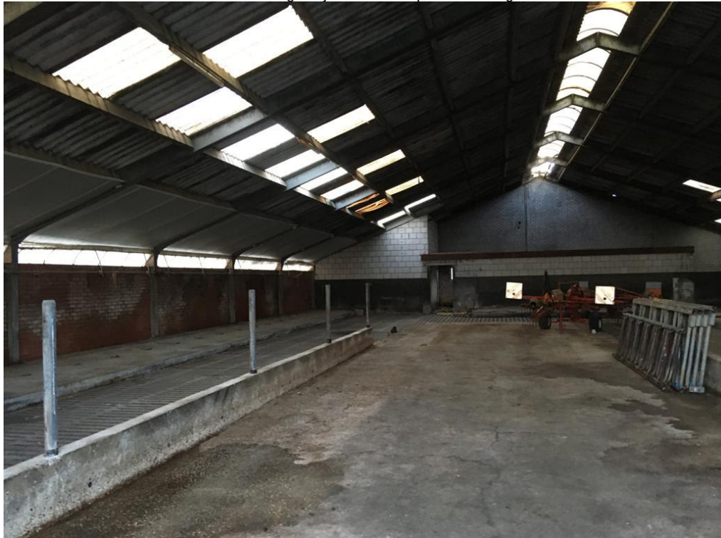
• Afbeelding 5: zij aanzicht te slopen bebouwing
