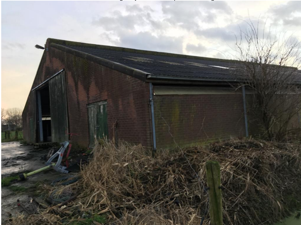
• Afbeelding 4: zij aanzicht te slopen bebouwing
