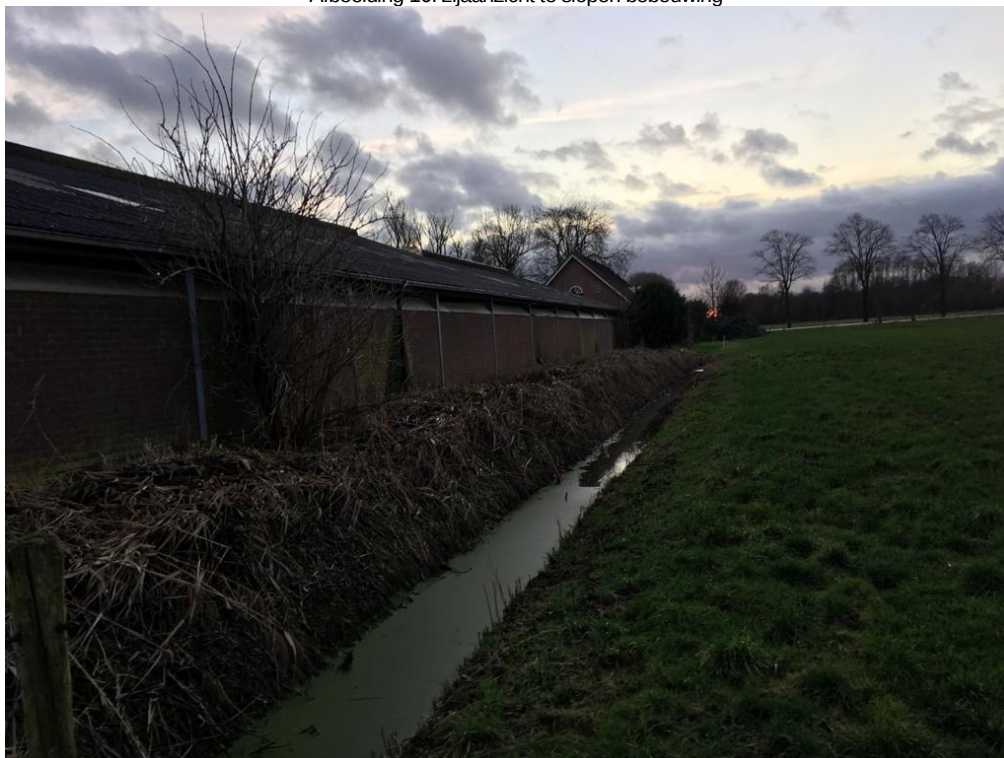
• Afbeelding 10: zijaanzicht te slopen bebouwing
