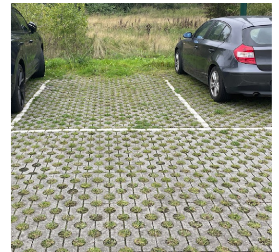
Grasbetonstenen voor de rijbaan en parkeerplaatsen
