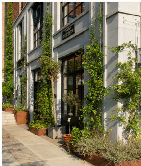
Kabels bevestigen op gevel
