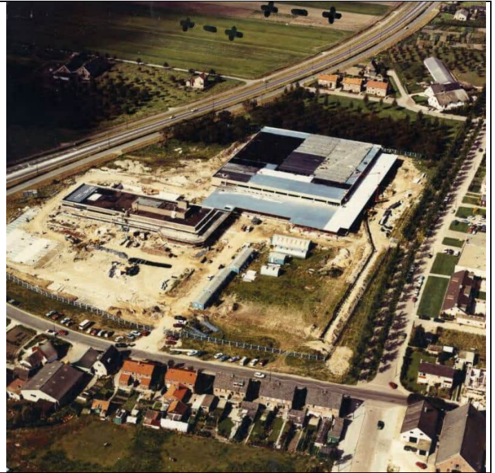
www.razu.nl – In aanbouw zijnde Kodak fabriek 1972
