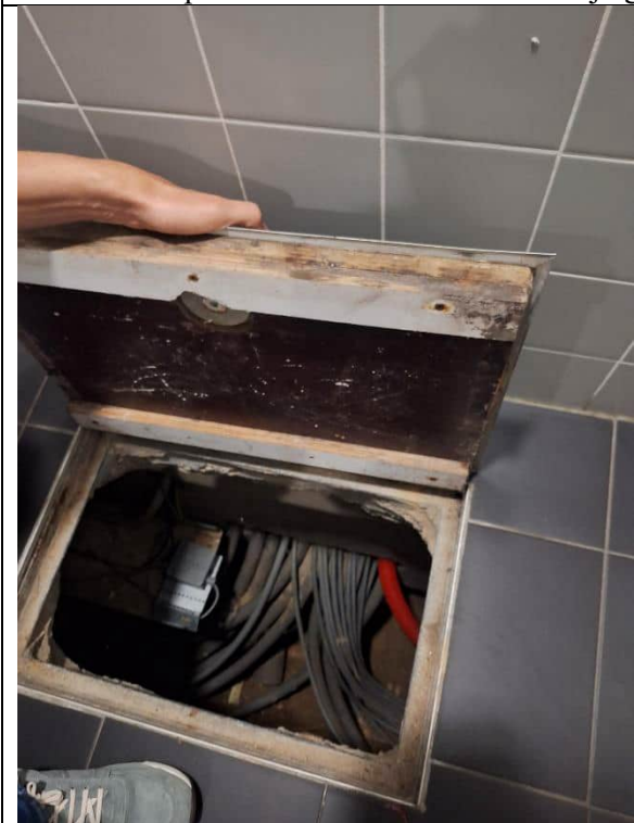
Foto 15: kruipluik met 'spaghetti' aan kabels en leidingen
