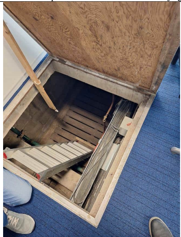
Foto 16: kruipluik met daaronder kabel goten, leidingen, vlonder en betonvloer
