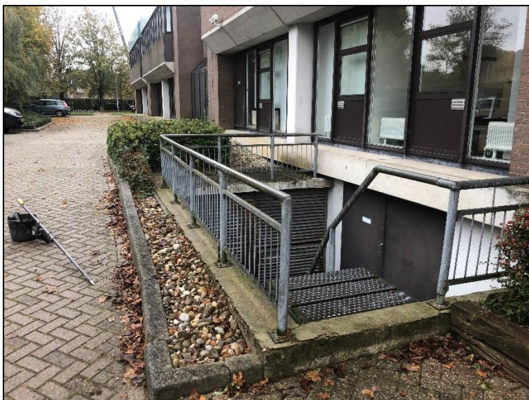
Figuur 1.4 Oostelijke ingang naar volledige onderkeldering van een van gebouwen.
