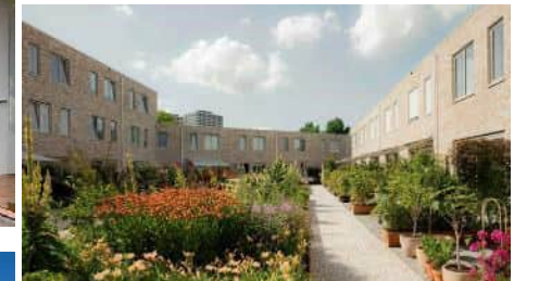
Buizenruimte aan een collectieve tuin
