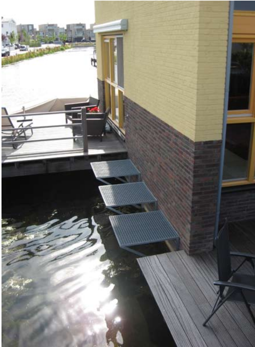
Zijgevel direct aan het water met informele ontsluiting.
