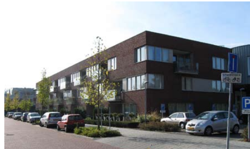
Langwerpig bouwvolume van drie lagen hoog. Eenvoudige, ingetogen architectuur. Referentie voor appartementencomplex.
