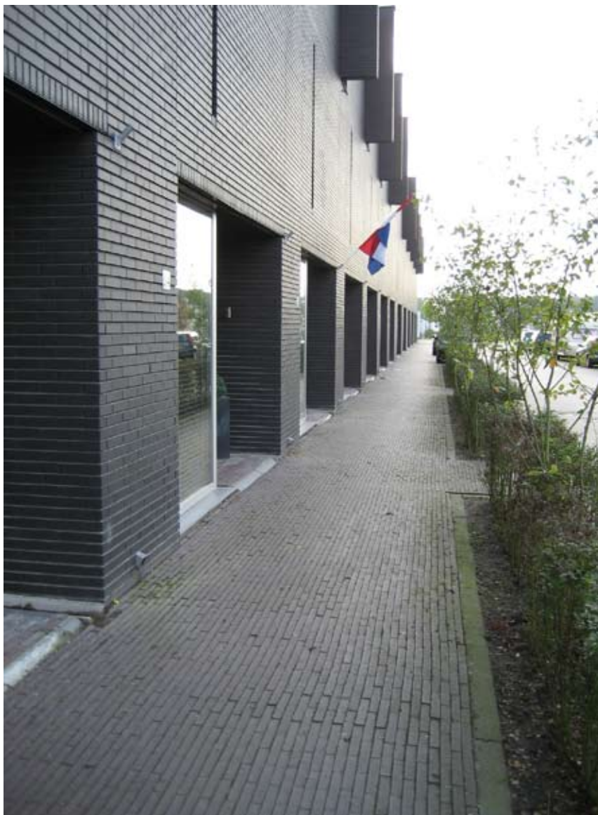
Rijwoningen direct grenzend aan openbare ruimte.
