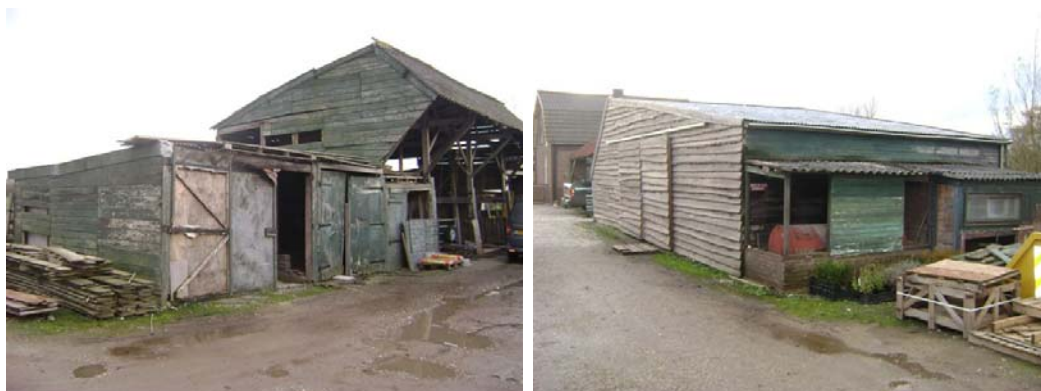
Bestaande bebouwing op het perceel Portengen 2
