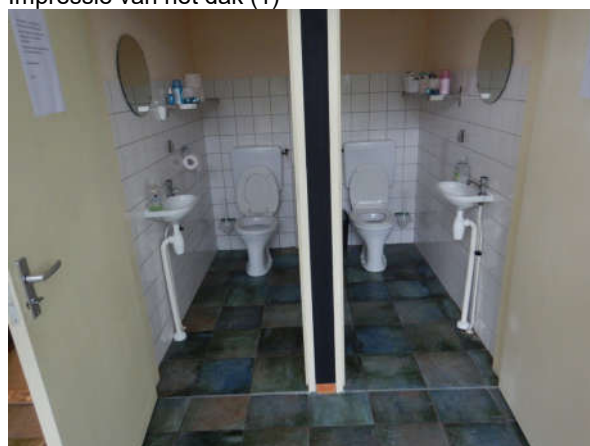
Vaste tegelvloeren niet opengebroken
