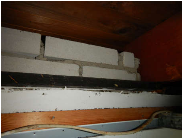
Impressie onder het verlaagd plafond (1)
