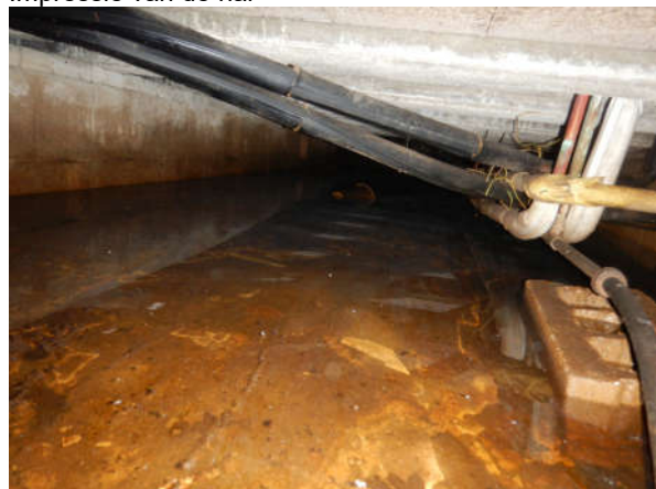
Impressie van de kruipruimte vol met water
