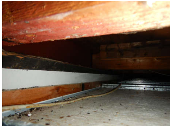
Impressie onder het verlaagd plafond (2)
