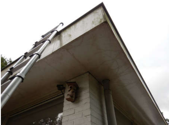
Impressie van de dakrand
