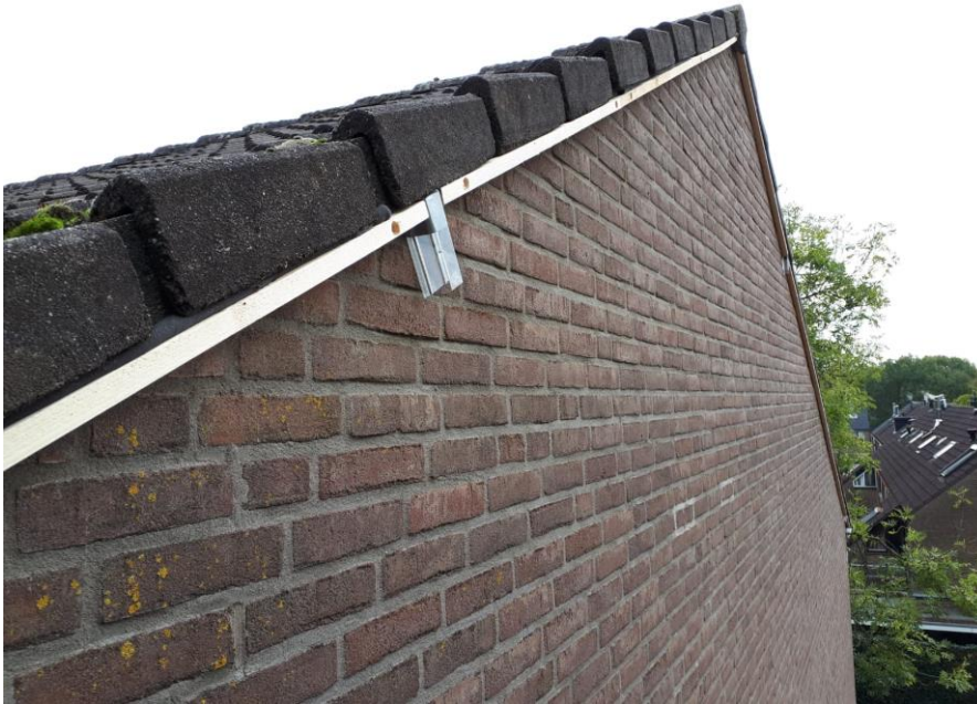
Detail: Exclusion flaps met panlatten en rugvulling.
