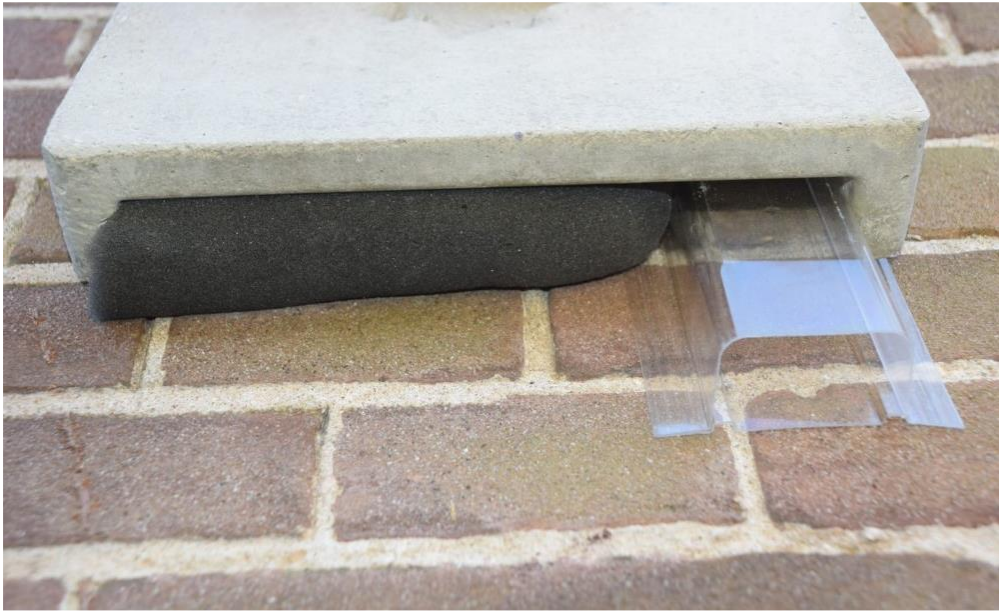
Details: Ongeslacht maken muurschaal door het plaatsen van een exclusion flap en toepassing van kitrugvulling.
