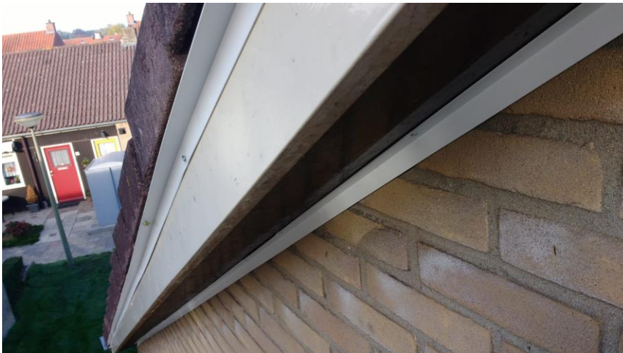
Detail: Hoekprofiel bij kantpannen.
