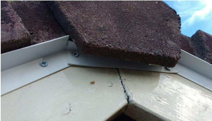
Detail: Hoekprofiel bij nokpan.
