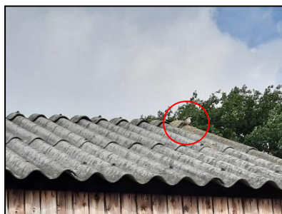
Figuur 15. Huismus op golfplaten dak van landbouwschuur 2 (rood omcirkeld).
