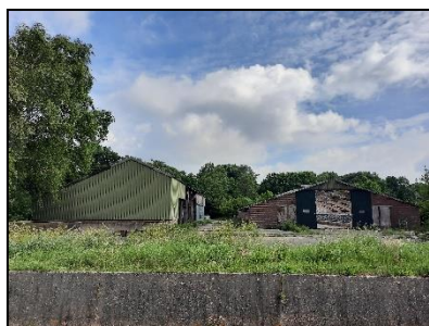
Figuur 3. Overzichtsfoto van de onderzoekslocatie vanaf het zuiden.
