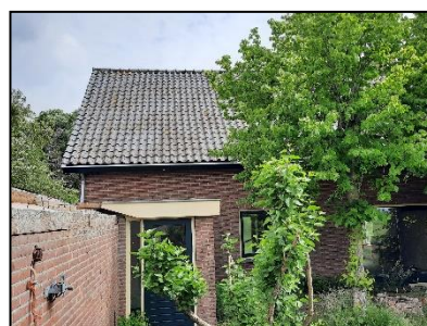
Figuur 8. Zuidelijke georiënteerde gevel van het woonhuis op de onderzoekslocatie.
