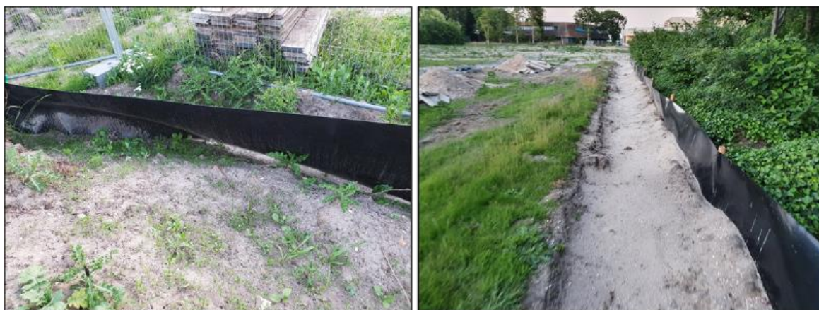
Figuur 3 Een incorrect geplaatst amfibiescherm (links). Een correct geplaatst amfibiescherm (rechts). Deze dienen minimaal 10 cm ingegraven te zijn (bron foto's: Blom Ecologie).
