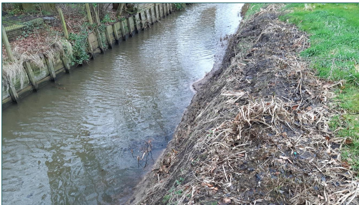
Figuur 3 De kavelsloot aan de zuidoostzijde bevat aan één zijde beschoeiing en aan de andere zijde een hoge oever.
