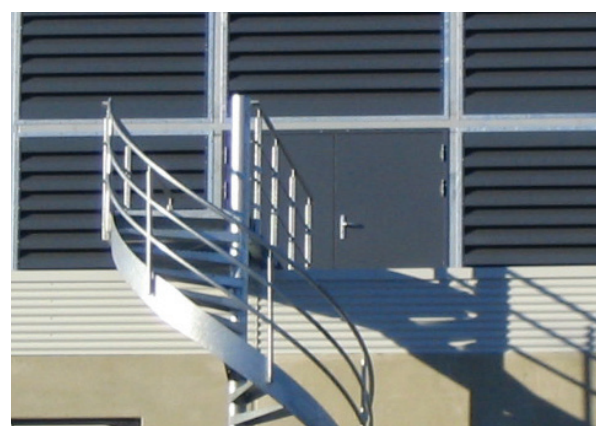
Geluid dempende roosters type AKR gemonteerd in staalconstructie
