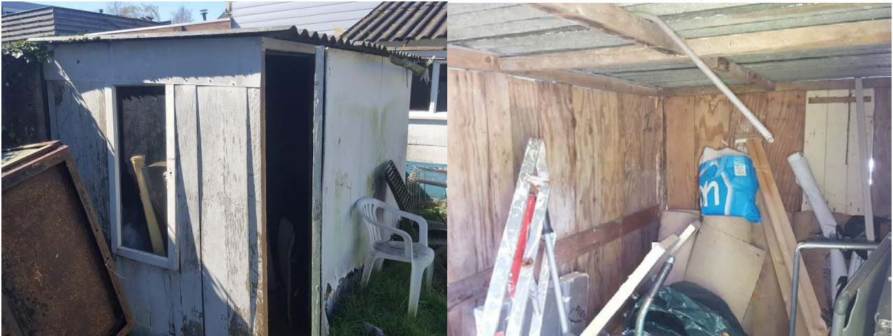
Figuur 15 Foto links: Gebouw (schuurtje) gelegen in de zuidwesten. Foto rechts: Binnenkant van het gebouw (schuurtje).
