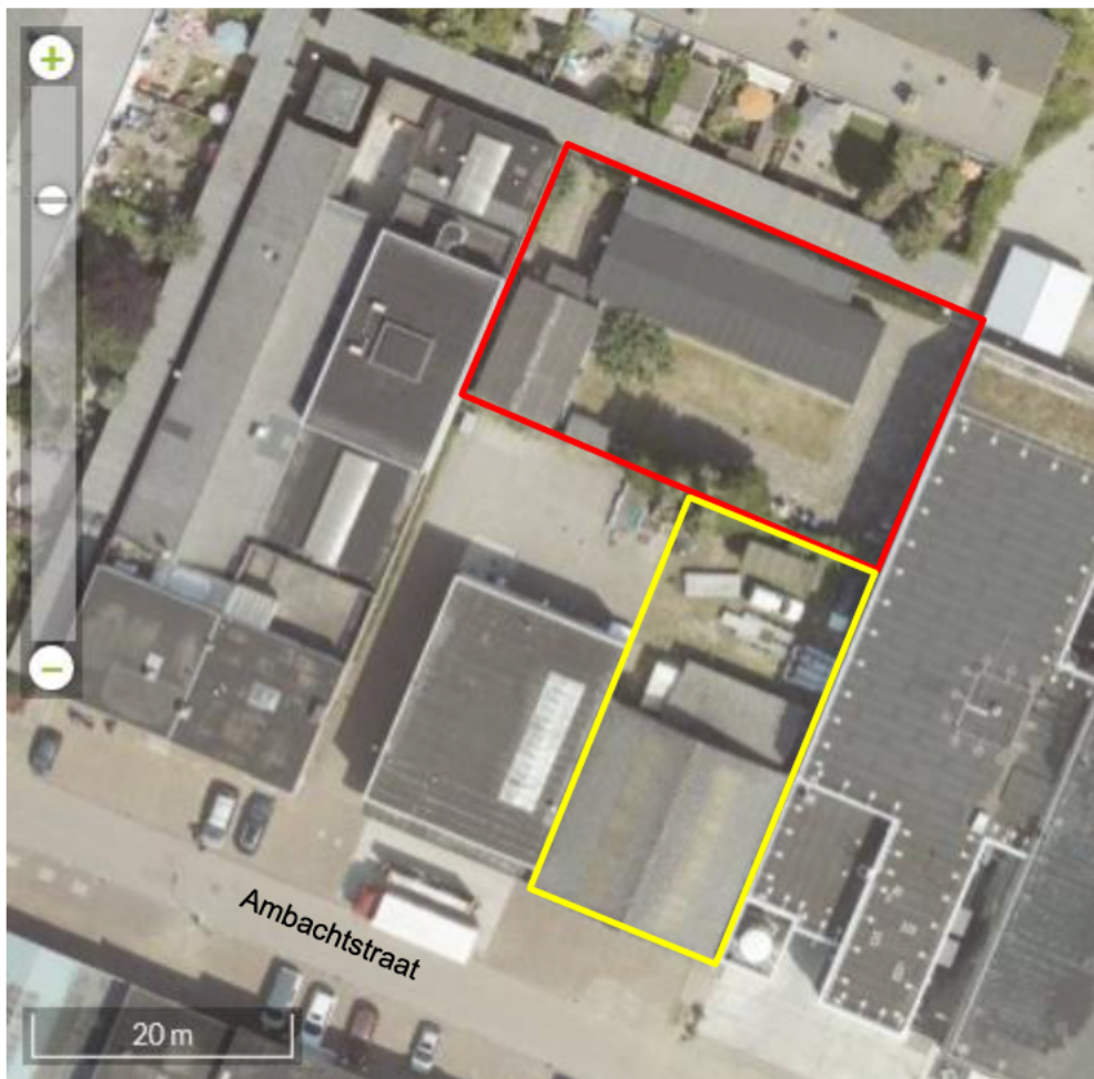
Figuur 1 Luchtfoto plangebied (www.globespotter.cyclomedia.com). Perceel Ambachtstraat 8 (geel omkaderd), perceel Troelstraweg 49a (rood omkaderd).
