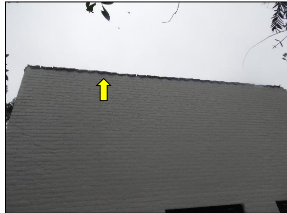
Figuur 10. Overhangende dakpannen geven toegang tot ruimtes in muren en onder het dak voor vleermuizen (bebouwing Frans Halslaan 80).
