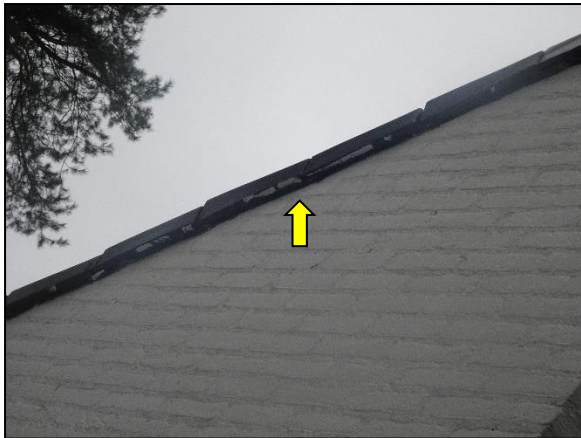
Figuur 9. Overhangende dakpannen geven toegang tot ruimtes in muren en onder het dak voor vleermuizen (bebouwing Frans Halslaan 80).
