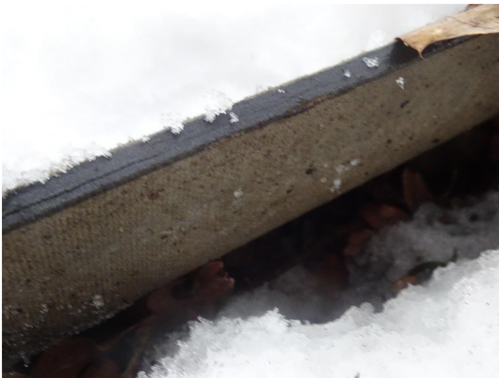
Foto 4. asbestverdacht plaatmateriaal
