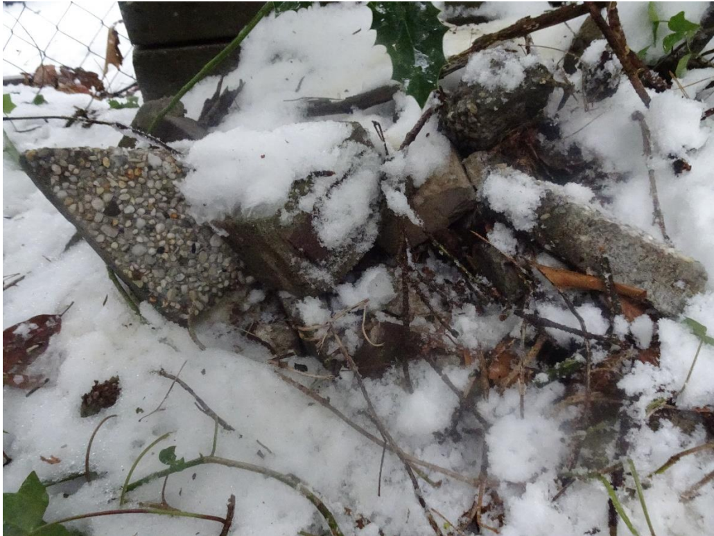
Foto 5. brokken grindtegels en baksteen
