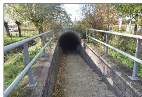
Tunnel onder de N412.
