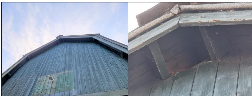
Figuur 3 De dakrand van schuur A op de planlocatie sluit aan, er zijn in deze schuur geen openingen aanwezig welke vleermuizen toegang kunnen verlenen tot de schuur.
