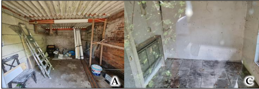
Figuur 4 Fotografische indruk van de binnenzijde van Schuur A en C. In alle te slopen bebouwing ontbreken spouwmuur en dakbeschot. De letters geven de schuren weer.
