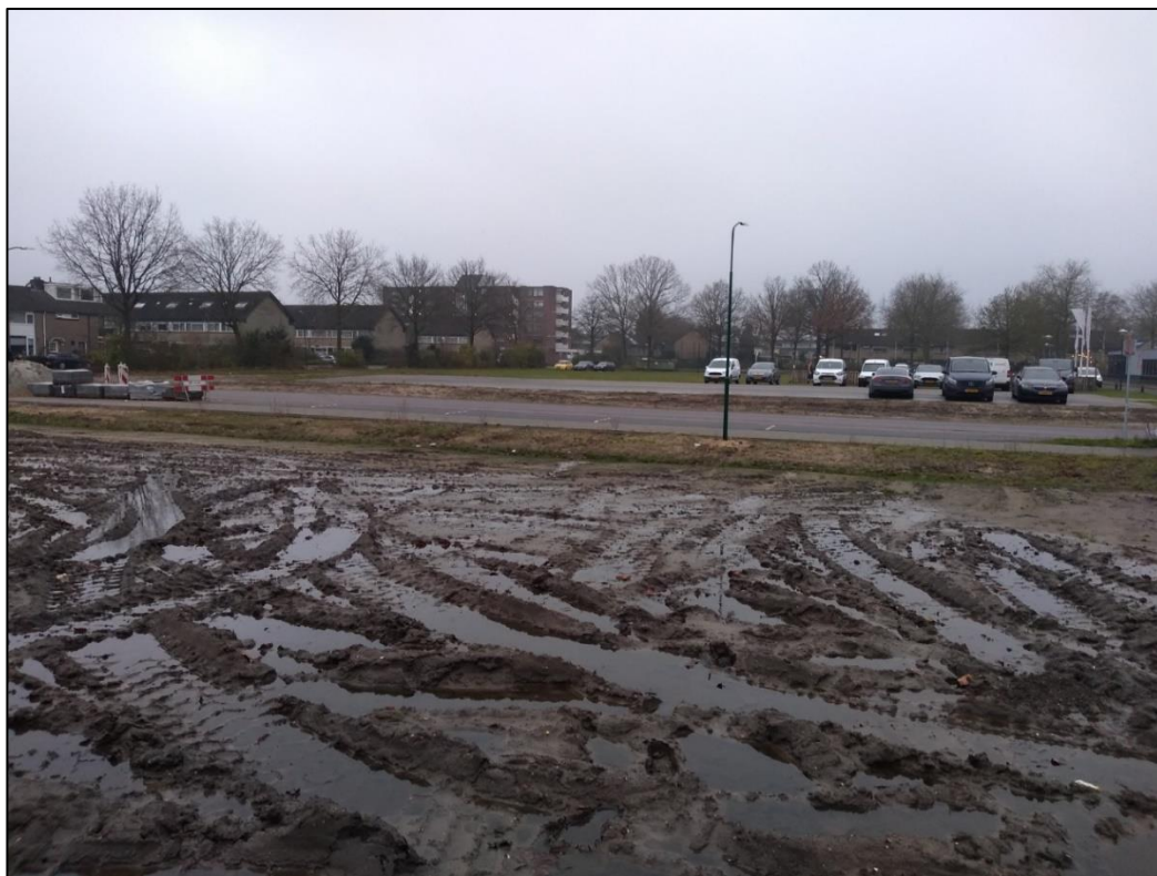
Afbeelding 21: Foto vanaf de oostzijde van het plangebied richting het zuidwesten met op de achtergrond de parkeerplaats op het H. Dunantplein.
