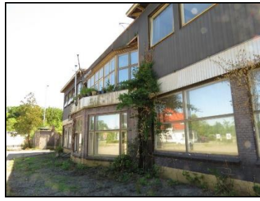
Figuur 4. Vooraanzicht van de gevel van het oudere deel van de bebouwing (oostelijke delen), gezien vanaf de Utrechtseweg.
