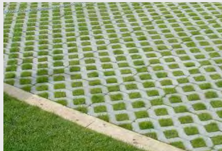
Halfverharding als inrit over een groenstrook langs de weg
