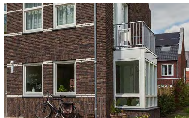
Eerste laag in baksteen, rest in hout
