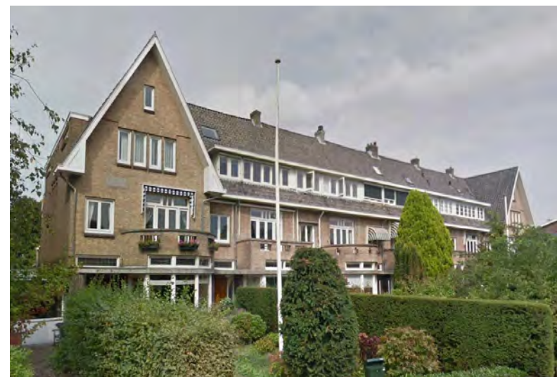
Referentiebeeld woningen met dwars- en langskappen
