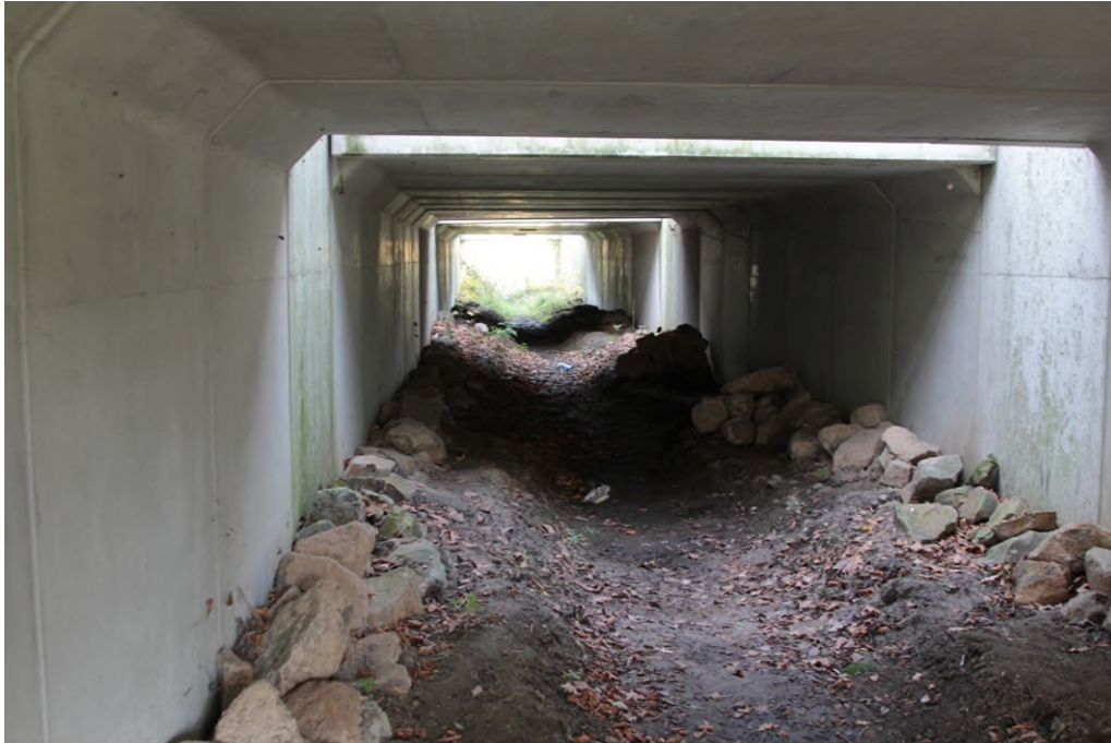
Faunapassage. Foto genomen vanuit het noorden.
