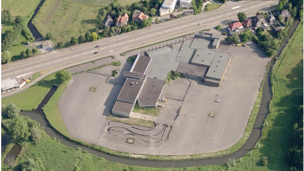
Luchtfoto van het plangebied (bron: BingMaps)
