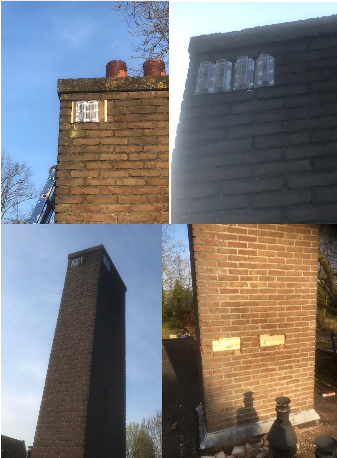
Figuur 1. Weergave van de geplaatste exclusion flaps over de open stootvoegen van de schoorsteen. Rechtsonder is te zien dat het gat, dat was gemaakt, weer is gedicht om te zorgen dat vleermuizen niet meer de schoorsteen kunnen betreden. Opname: BBWS, 8 april 2020
