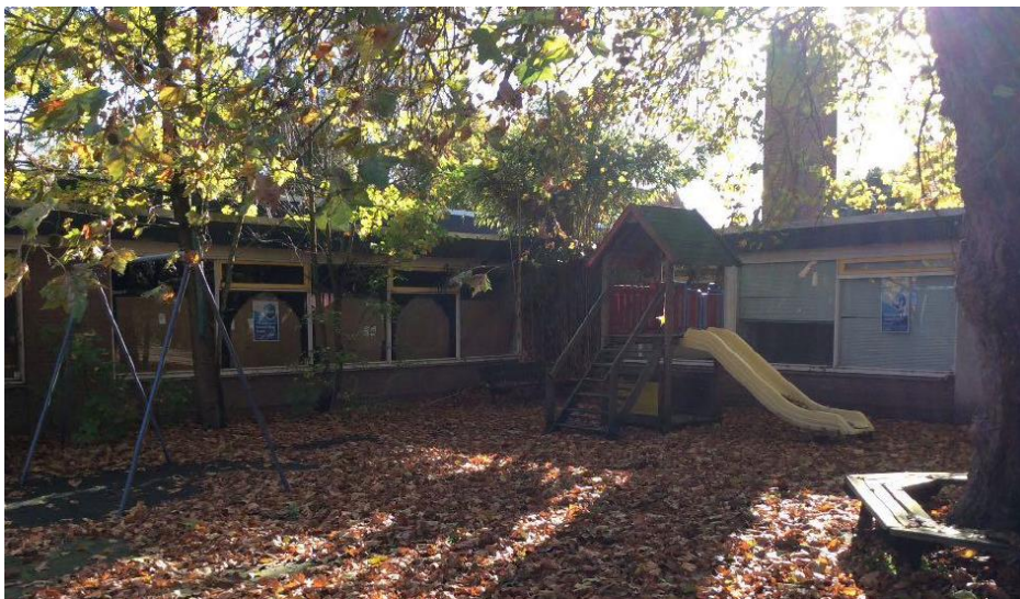
Figuur 5 Impressie te slopen bebouwing
