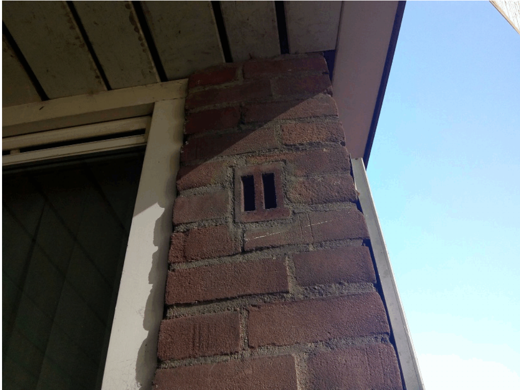
Steen met spleetvormige openingen, mogelijk jaarrond geschikt voor vleermuizen
