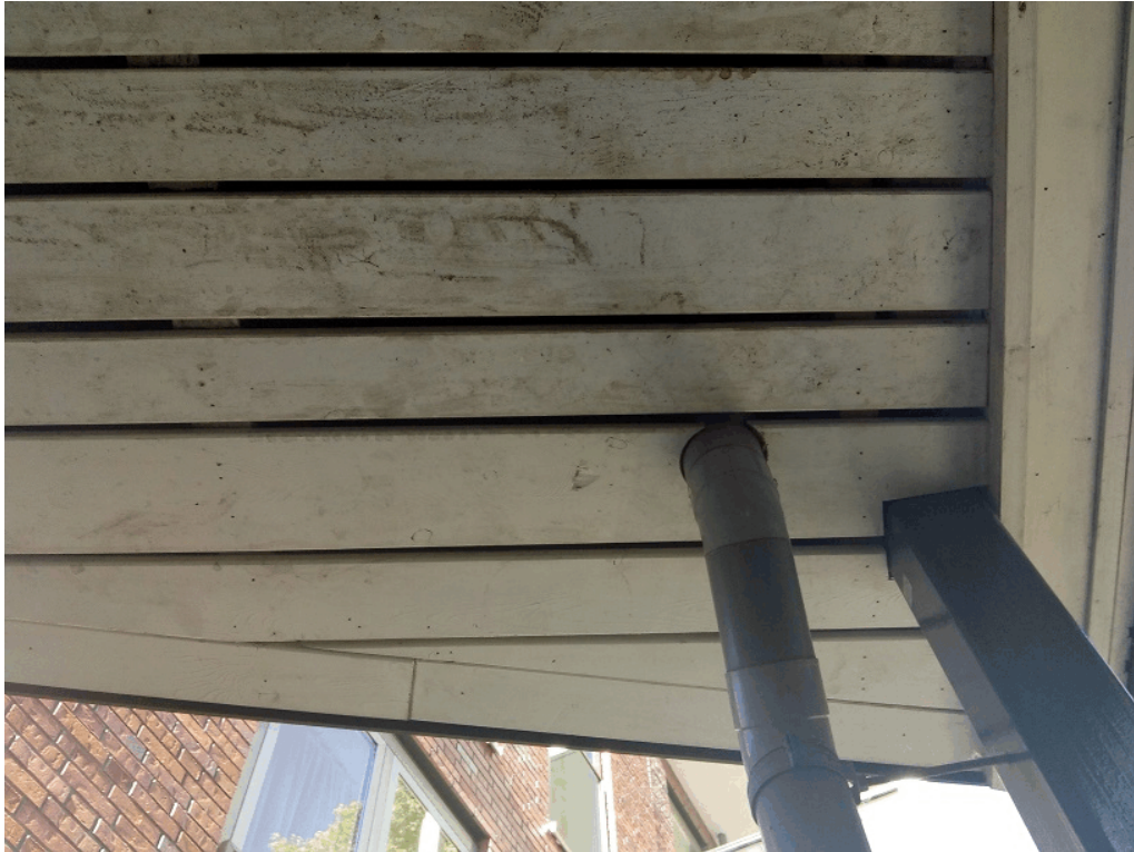
Onderkant van afdakje met ruimtes tussen planken en aansluiting regenpijp
