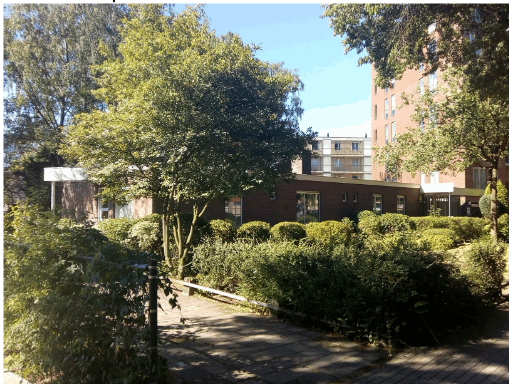
Aanzicht van het pand uit het noordoosten.
