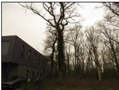
Figuur 3. Onderzoekslocatie vanaf oostzijde.
