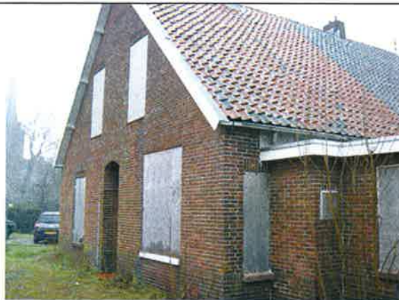
Foto 2: gevels / dak geen asbest aangetroffen
