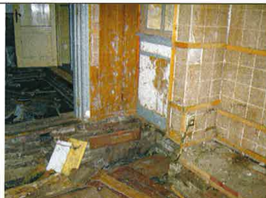
Foto 4: keuken geen asbest aangetroffen
