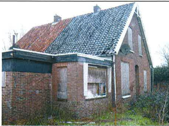
Foto 1: gevels / dak geen asbest aangetroffen
