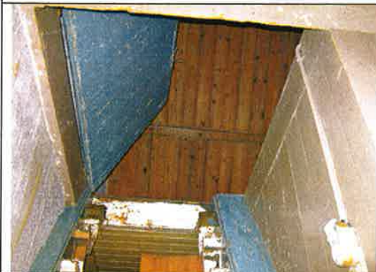
Foto 3: zolder dakbeschoot geen asbest aangetroffen
