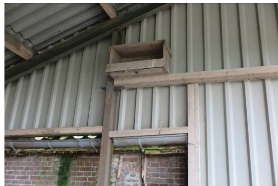
Te slopen open schuur
