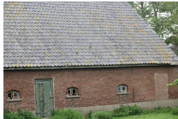
Te slopen dichte schuur
