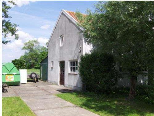
Figuur 2.8 Beton verharding
