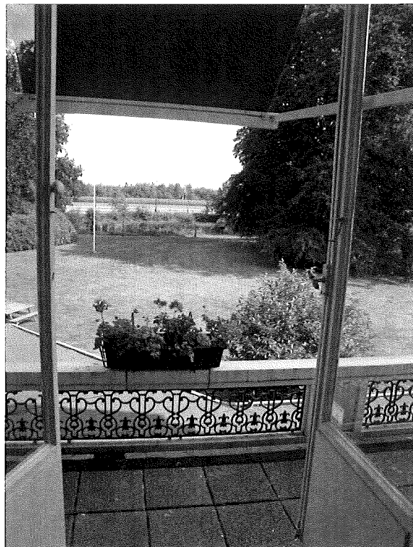
Afb. 50 Uitzicht vanaf de eerste verdieping van het landhuis (oostelijke zichtas). De balkons op de verdieping zijn met een houten balustrade (nieuw) afgezet, met daarin de originele, gietijzeren sierhekjes.
