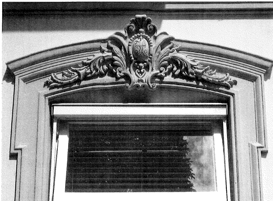
Afb. 48 Detail van venster in de zuidgevel, de bovenkant van een getoogde vensteromlijsting. Boven op de boog is een fors uitgevoerde versiering aangebracht, een cartouche met bladwerk, waarop het monogram met de letters V en H, het monogram van de familie Van Hengst is gegrift. Het materiaal van de grijs geschilderde kuif is vermoedelijk terracotta.
