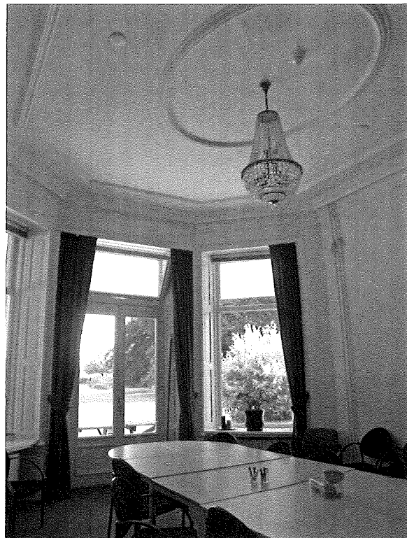
Afb. 54 In de grote tuinkamer aan de oostzijde is het stucplafond met rijk geprofileerde lijsten in het zicht gebleven.
