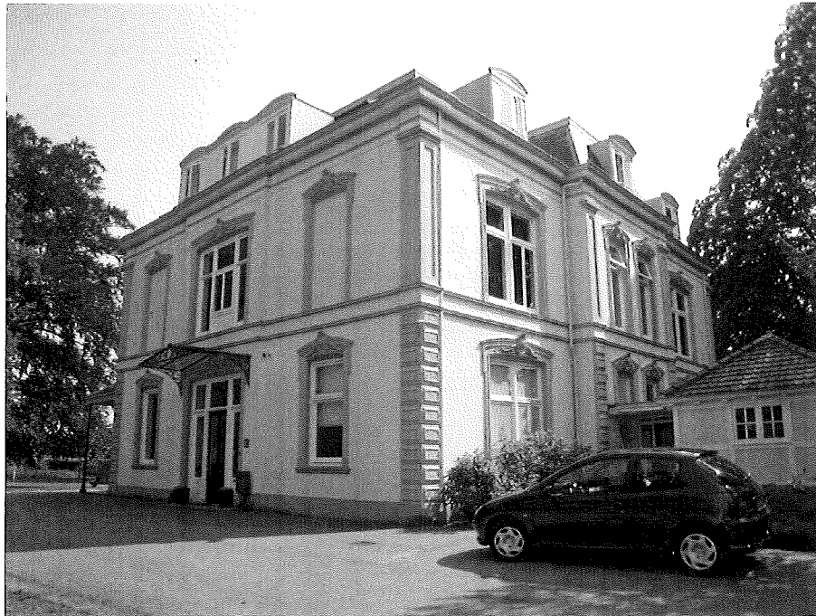
Afb. 47 Het landhuis gezien vanaf het noordwesten. In de noordgevel bevindt zich de hoofdingang. Tegen de westgevel is een laag bouwvolume aangebouwd.
