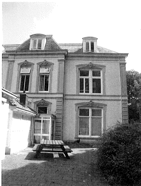
Afb. 51 De westgevel met de aanbouw die in 1951 tegen het middenvak is aangebouwd.
