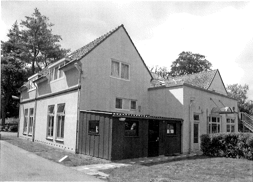
Afb. 60 De achtergevel van het koetshuis. Bij de achtergevel valt op het buiten de zijvleugels uitgebouwde bouwdecl. Met een stalen trap is het platte dak of dakterras te bereiken, en daar bevinden zich de toegangen tot de zolderverdieping.
