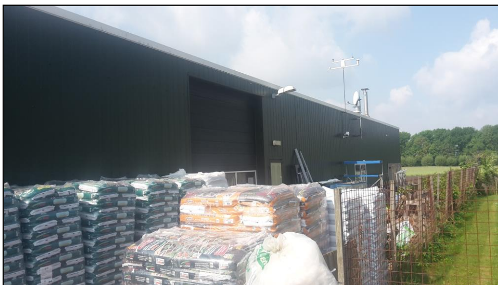
Foto 2: Opslagloods binnen het plangebied
