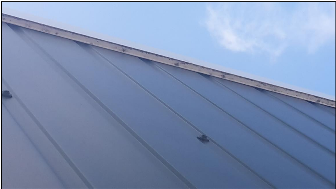
Foto 5: De loods is opgetrokken uit metalen golfplaten
