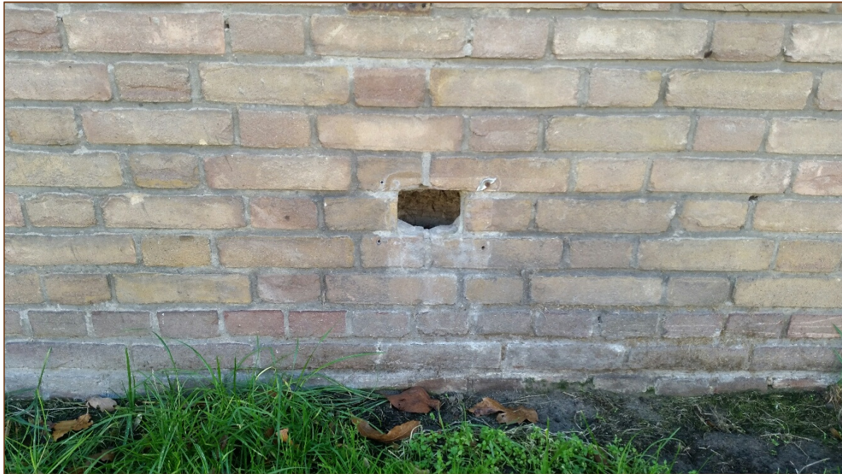
Foto 5. Opening naar spouw via een verwijderd ventilatierooster.
