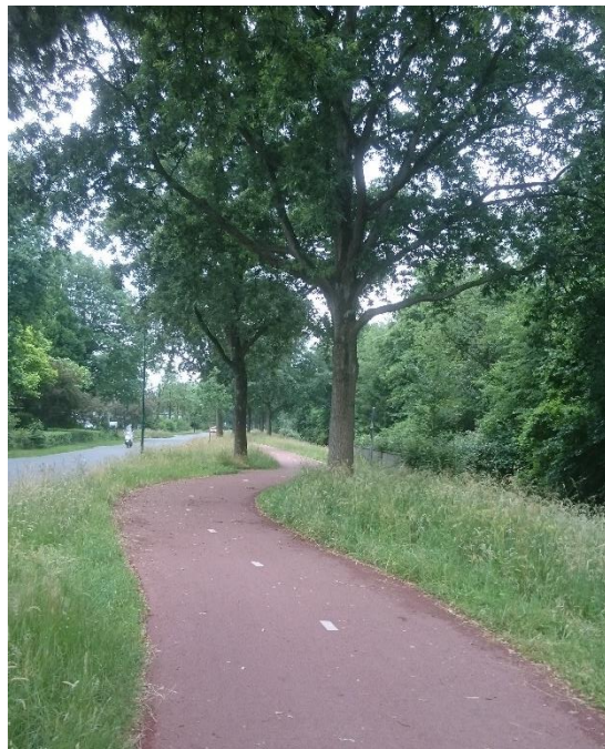
Fietspad tussen eiken op Weltevreden in De Bilt. Dit fietspad is ca. 10 jaar geleden aangelegd met een verhoogd peil t.o.v. het oorspronkelijke maaiveld. De bomen (in dit geval moseiken) hebben hier geen schade van ondervonden terwijl het pad binnen hun kroonprojectie is aangelegd.
