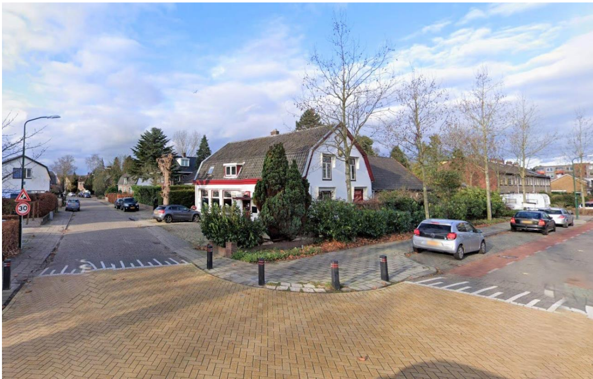
Het Wapen van Beerestein in betere tijden, bestaande uit een horecabedrijf met 2 (kleine) appartementen op de bovenverdieping
